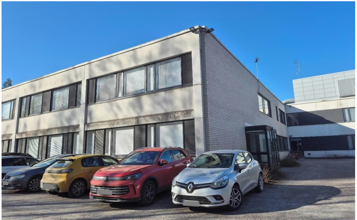
Kuva 18. Vuonna 1979 valmistuneen rakennusosan julkisivut ovat kahi-tiiltä ja betonia. Ikkunoiden välisat ovat pellitettyjä.
