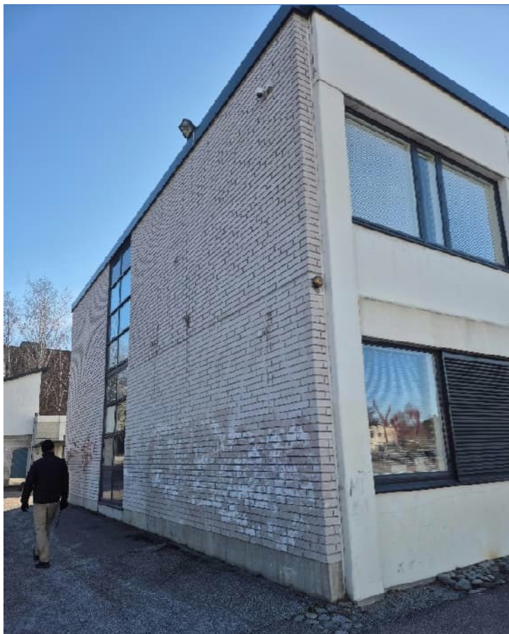
Kuva 27. Vuonna 1988 rakennetun laajennusosan päätyseinä. Julkisivut ovat kahi-muurattuja ja betonielementtejä.
