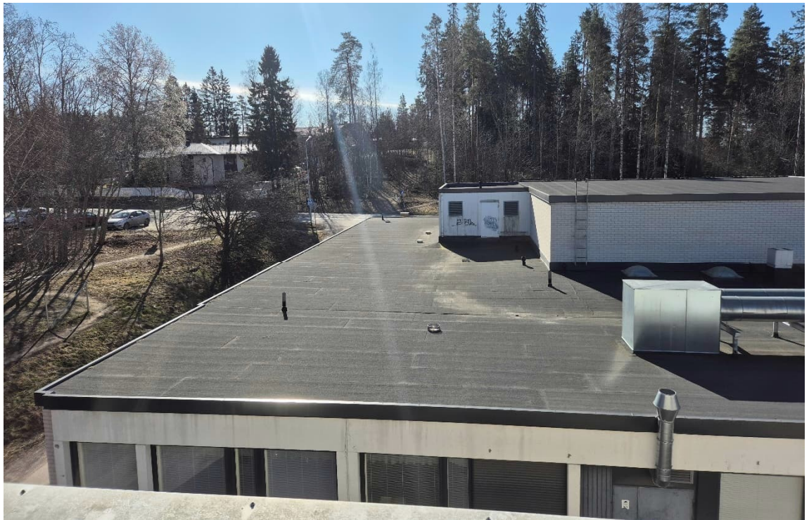
Kuva 13. Alkuperäisen rakennusosan ns. keittiösiiven vesikatto.
