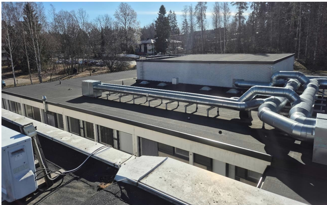
Kuva 11. Alkuperäisen rakennusosan keittiösiiven vesikatto on uusittu vuonna 2016. Kuvassa näkyy vesikaton päällä olevan auditorion yläosan (alunperin ruokasali) ulkoseinät, jotka ovat puhtaaksi muurattua kahiseinää.
