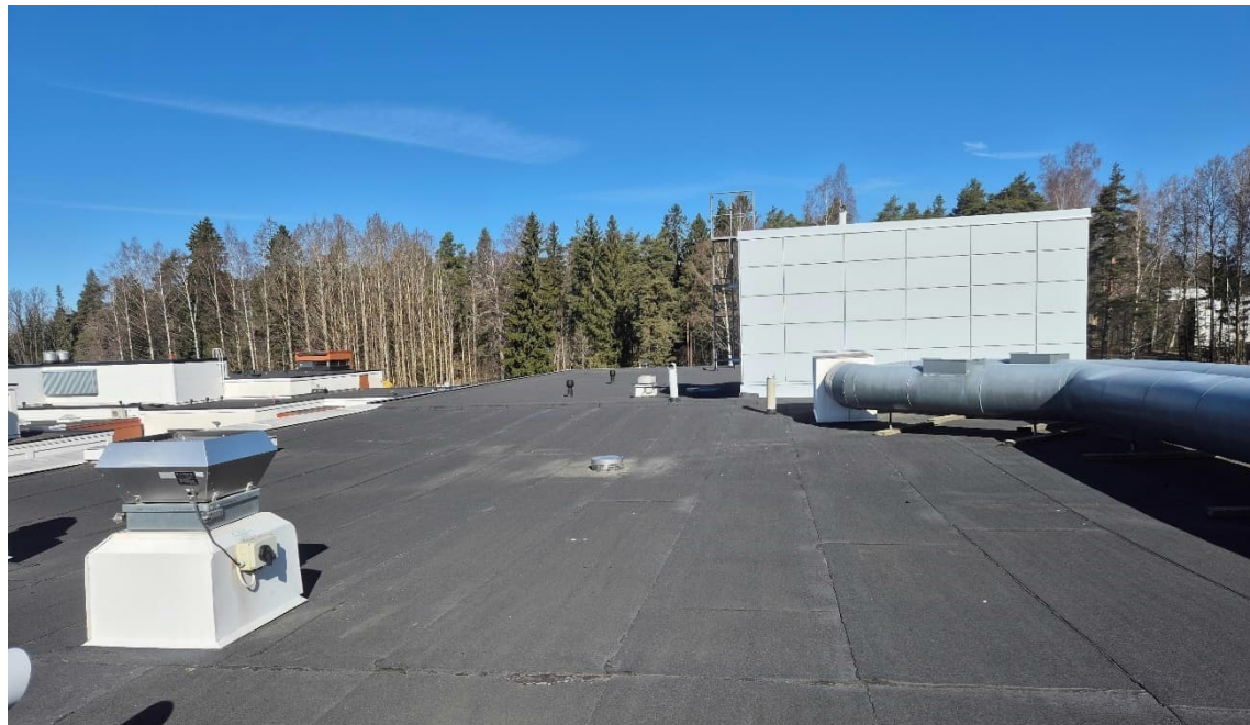
Kuva 35. Vuonna 2006 rakennetun laajennusosan vesikatto ja iv-konehuone.
