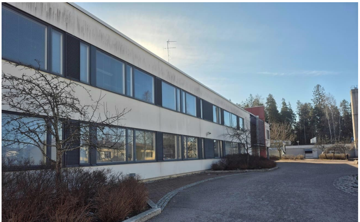
Kuva 32. Laajennusosan julkisivua vuodelta 2006.
