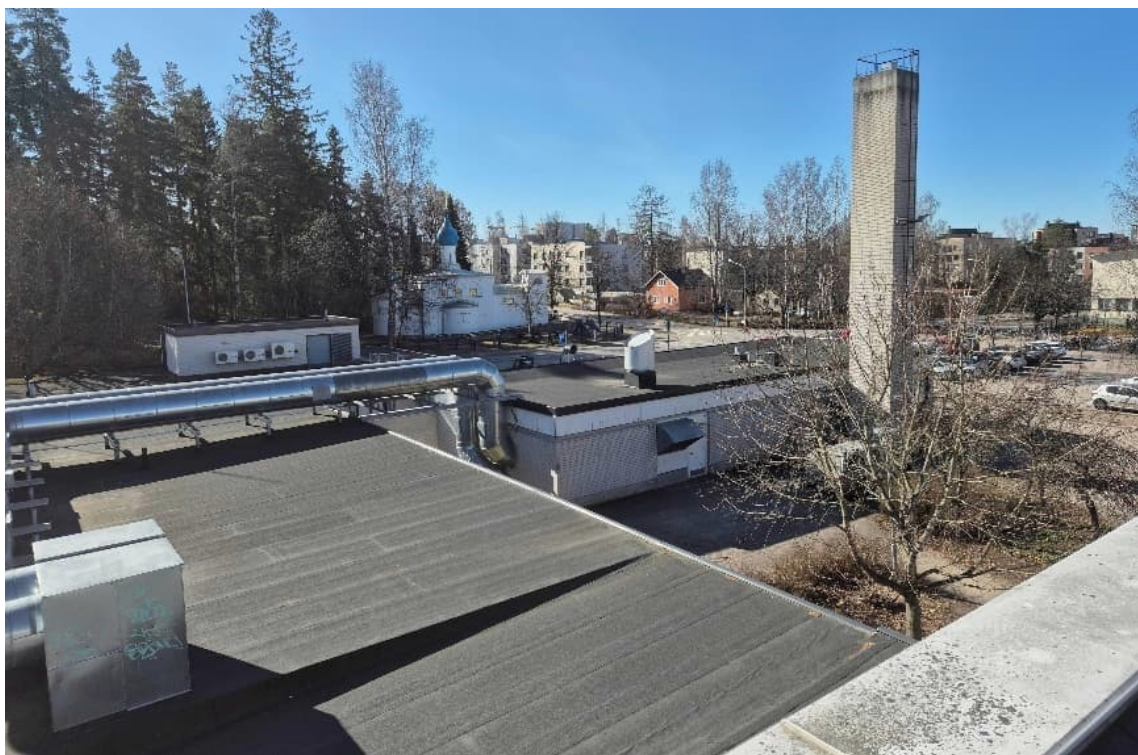
Kuva 12. Kuvassa näkyy keittiösiiven ja lämpökeskuksen vesikatot, jotka on uusittu vuonna 2016. Lämpökeskuksen julkisivut ovat puhtaaksi muurattua kahi-tiiltä. Lämpökeskuksen vieressä on vanha tiilipiippu.
