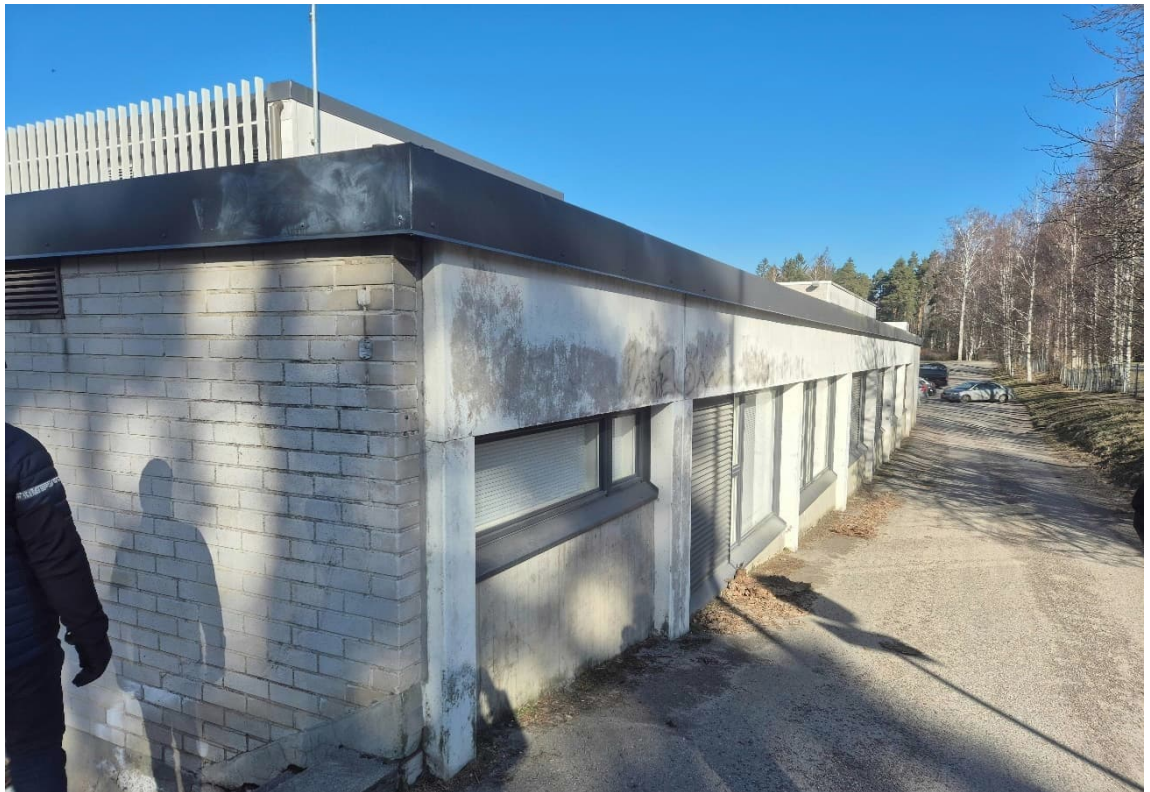
Kuva 8. Alkuperäisen rakennusosan kahi-muurattua ja betonista julkisivua.
