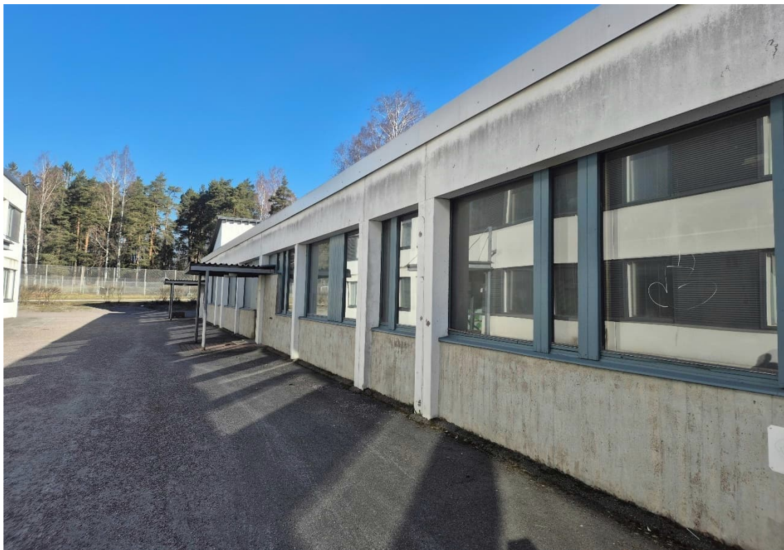
Kuva 10. Teknisen työn rakennusosan betonijulkisivua ja alkuperäiset puuikkunat. Ikkunoiden välissä olevat peltiverhoillut osuudet ovat oletettavasti myös alkuperäisiä.
